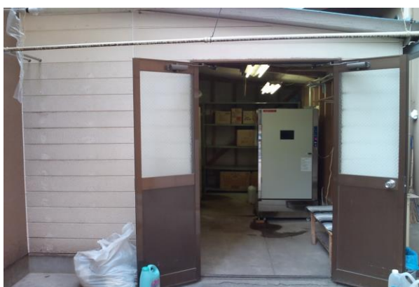
大阪府内 特別養護老人ホーム (別棟洗濯室内)
